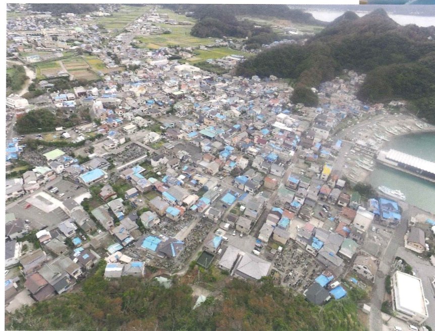
(まだ屋根のブルーシートが残っています)
